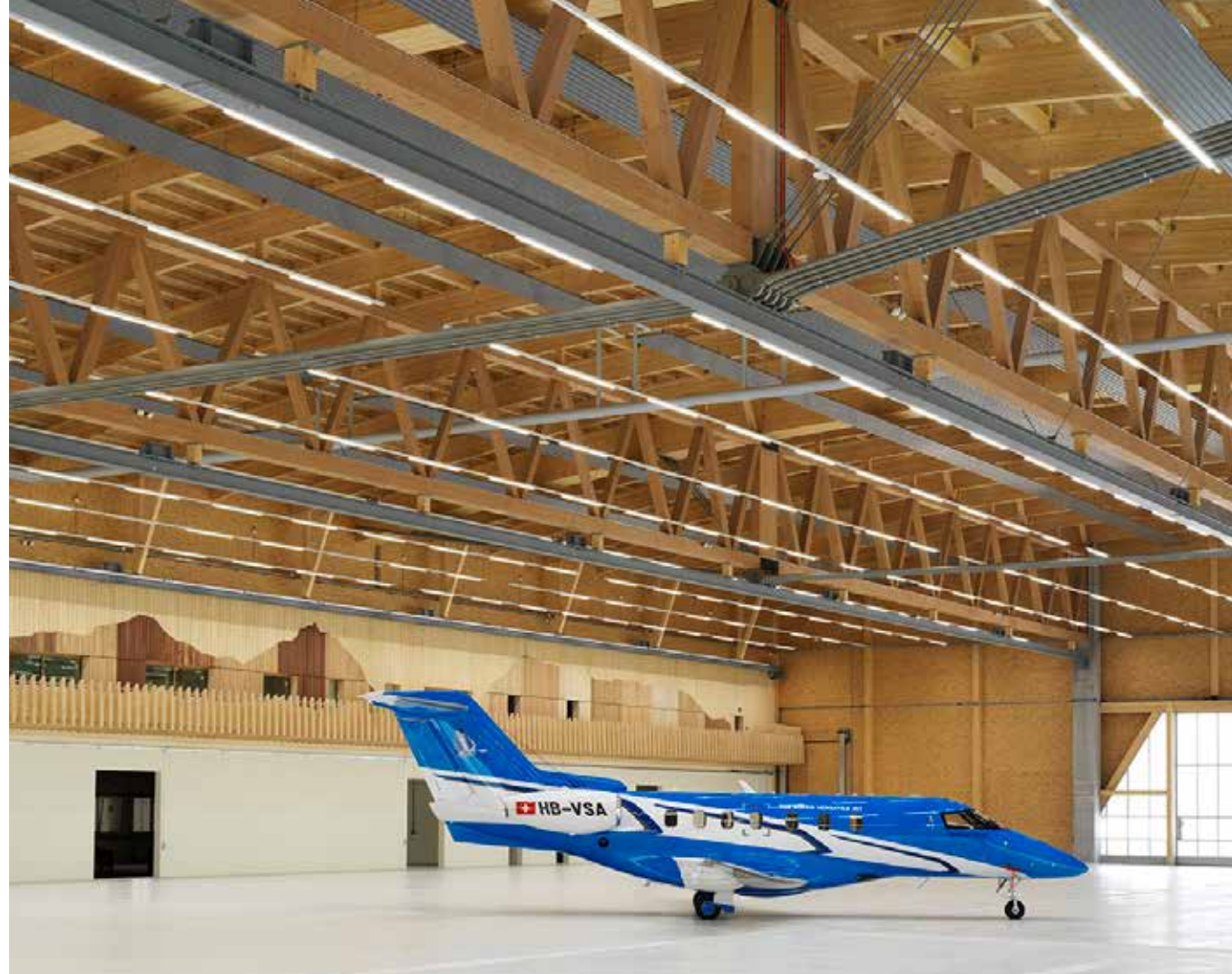
Die Dimensionen der Holztragwerke werden immer grösser, darum empfiehlt sich unter gewissen Umständen die Holzfeuchtigkeit zu monitorisieren.
